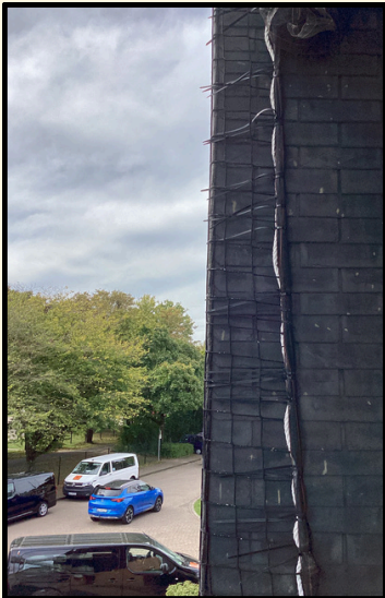
Die alte Fassade ist mit einem Netz gesichert.
